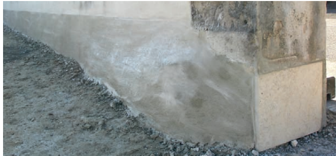
Eine klare farbliche Linie trennt die beiden Mauerteile. Der freigelegte Sockel wurde mit Versetzmörtel stabilisiert.
