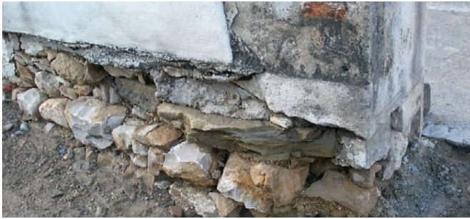
Der alte Mauersockel bestand aus einem Gemisch verschiedener, mehrheitlich kleinformatiger Steinarten.
