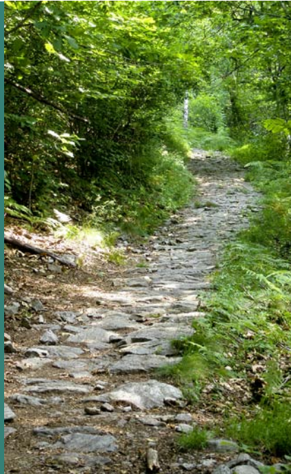
Mit formwilden 2-Mann-Steinen gepflasteter Weg.
