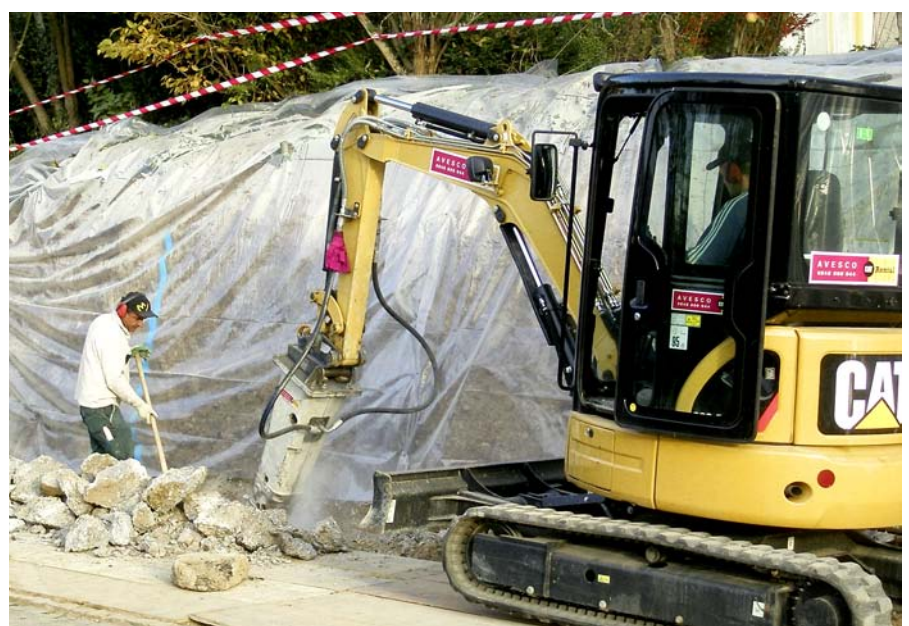
Dank eines Baggers mit Abbaueisen wurden die oberen 20 cm des massiven, alten Fundamentes in etwas mehr als einem halben Tag abgetragen.
