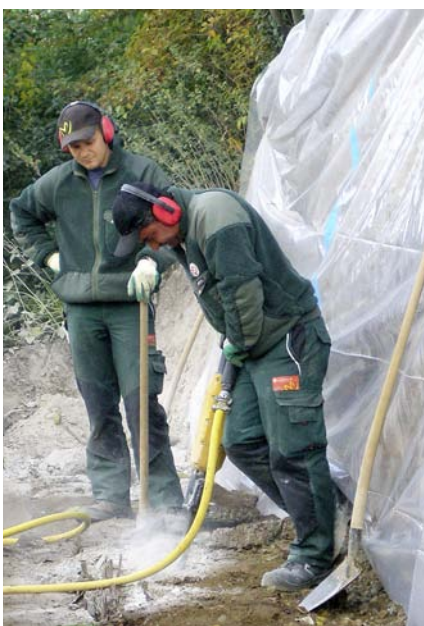
Vergebliche Mühen, das alte Fundament effizient abzuspitzen.
