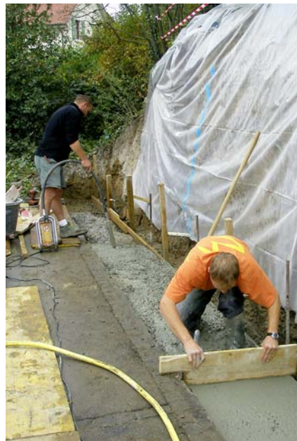
In den Zwischenräumen, wo einst die Bahnschwellen standen, wurde der Beton mit dem Nadelvibrator intensiv verdichtet.
