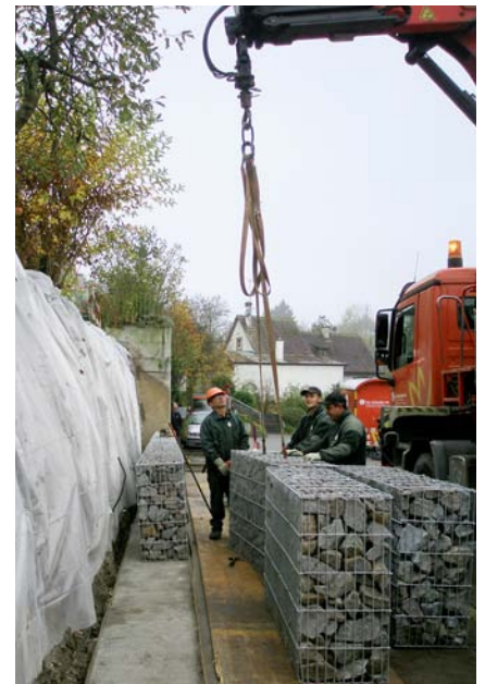
Die mit Lkw angelieferten fertig gefüllten Steinkörbe liessen sich mit dem angebauten Kran schnell abladen und versetzen.
