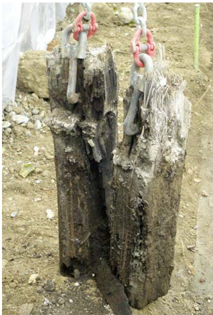
Der einbetonierte Teil der Bahnschwellen konnte nur mithilfe von Kette, Haken und der Zugkraft eines Baggers aus dem Fundament gerissen werden.
