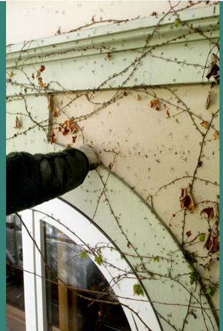
Die Bearbeitung der wertvollen Fassade verlangte Handarbeit und viel Geduld.
