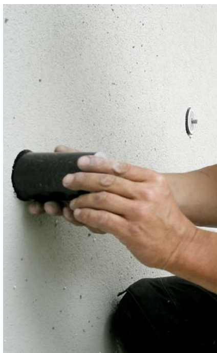
Die individuell zugeschnittene, wärmege­däm­mte Stützhülse wird in den Hohlraum der Dämmung eingepasst.
