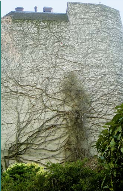
Einem Fischernetz ähnlich überzieht Parthenocissus tricuspidata das Gebäude.
