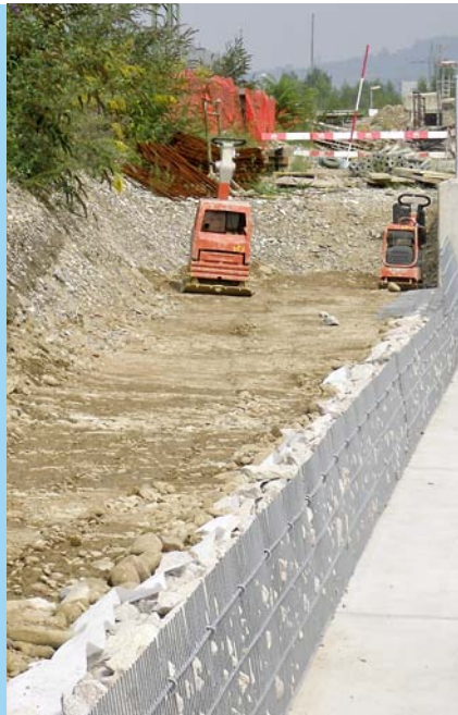
Jede Elementreihe wird mit kiesigem Material hinterfüllt und verdichtet.
