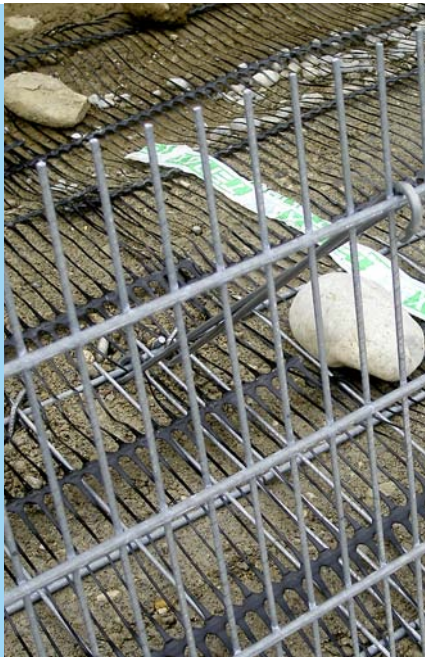
Das schwarze Kunststoffgewebe dient als Erdbewehrung.
