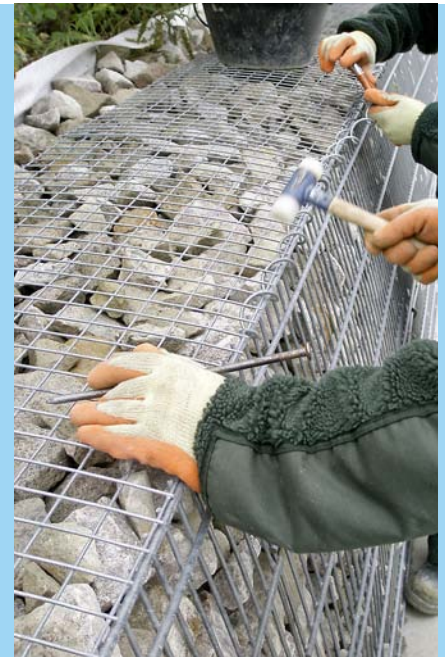
Eine Metallspirale verbindet das Frontelement mit dem Deckelement.
