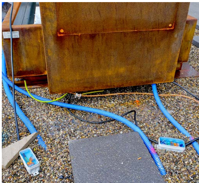
Verschiedenste Leitungen für das Funktionieren des Licht- und Wasserspiels wurden im Kiesbett verlegt.
