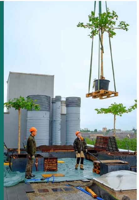
Ein Pneukran hob einen grossen Teil des Materials auf das Dach.
