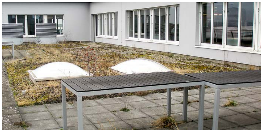
Oft sind Dachflächen vielerorts wenig gestaltete und kaum attraktive Aussenräume – ein grosses Potenzial für schöne Dachgärten.
