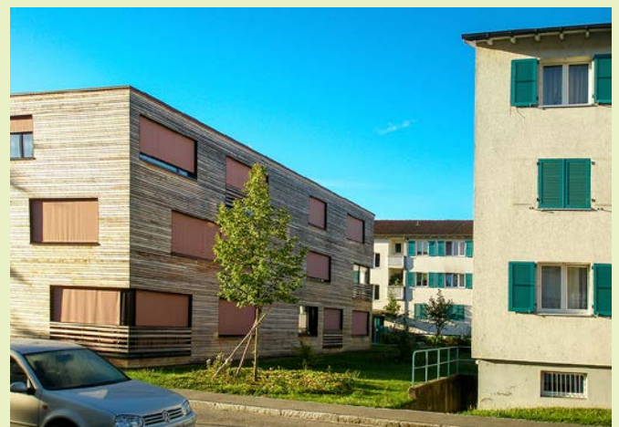
Grüne «Restflächen» in verdichteten Quartieren erschweren einen attraktiven Dialog zwischen dem Innen- und dem Aussenraum.
