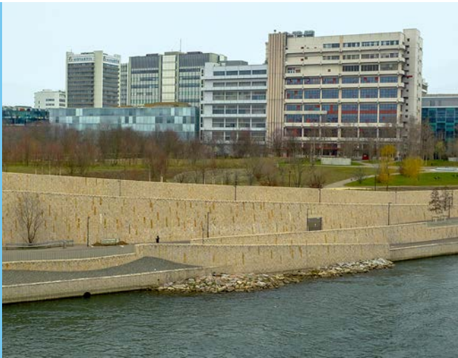
Neue Naturbilder im urbanen Raum sollen für wohnliche und atmosphärische Städte sorgen.
