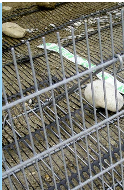
Das schwarze Kunststoffgewebe dient als Erdbewehrung.
