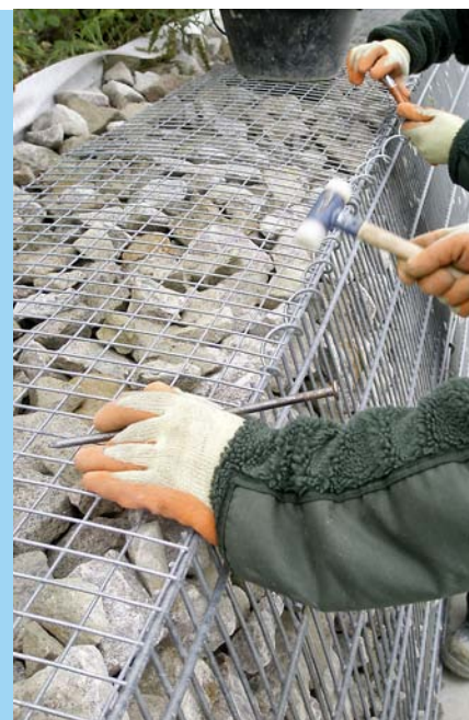
Eine Metallspirale verbindet das Frontelement mit dem Deckelement.
