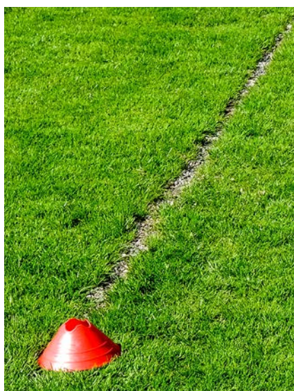
Verbindung zu den Saugerleitungen dank neuen Sickerschlitzten.
