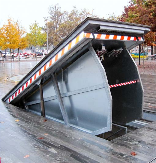
Eine gute Zugänglichkeit gewährleistet eine optimale Anlieferung von Material und Ersatzteilen.
