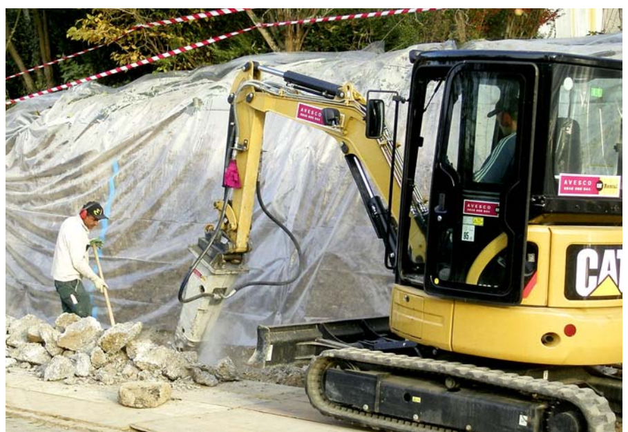
Dank eines Baggers mit Abbauphammer wurden die oberen 20 cm des massiven, alten Fundamentes in etwas mehr als einem halben Tag abgetragen.
