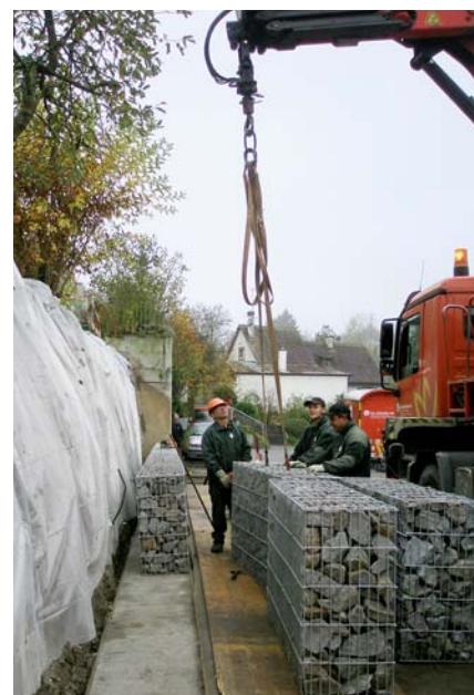
Die mit Lkw angelieferten fertig gefüllten Steinkörbe liessen sich mit dem angebauten Kran schnell abladen und versetzen.
