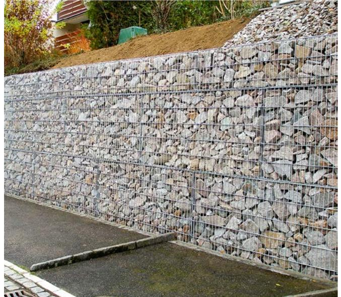
**Mauern aus Steinkörben stützen Böschungen durch ihr Eigengewicht. Durch falsche Bauweise können Korbelemente unter anderem in den Fugen kippen oder weggleiten.**
